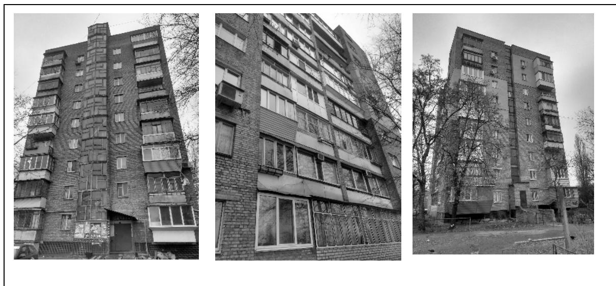
Рисунок 1 - Загальний вигляд зовнішніх стін будівлі
