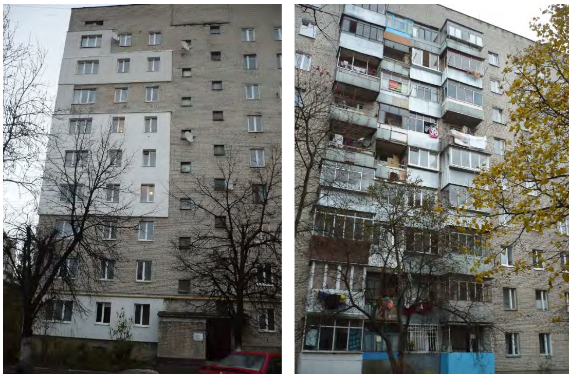
а) б) Рисунок 1 – Приклади хаотичного утеплення будівель мешканцями: а) латкової термомодернізації, б) засклення балконів
