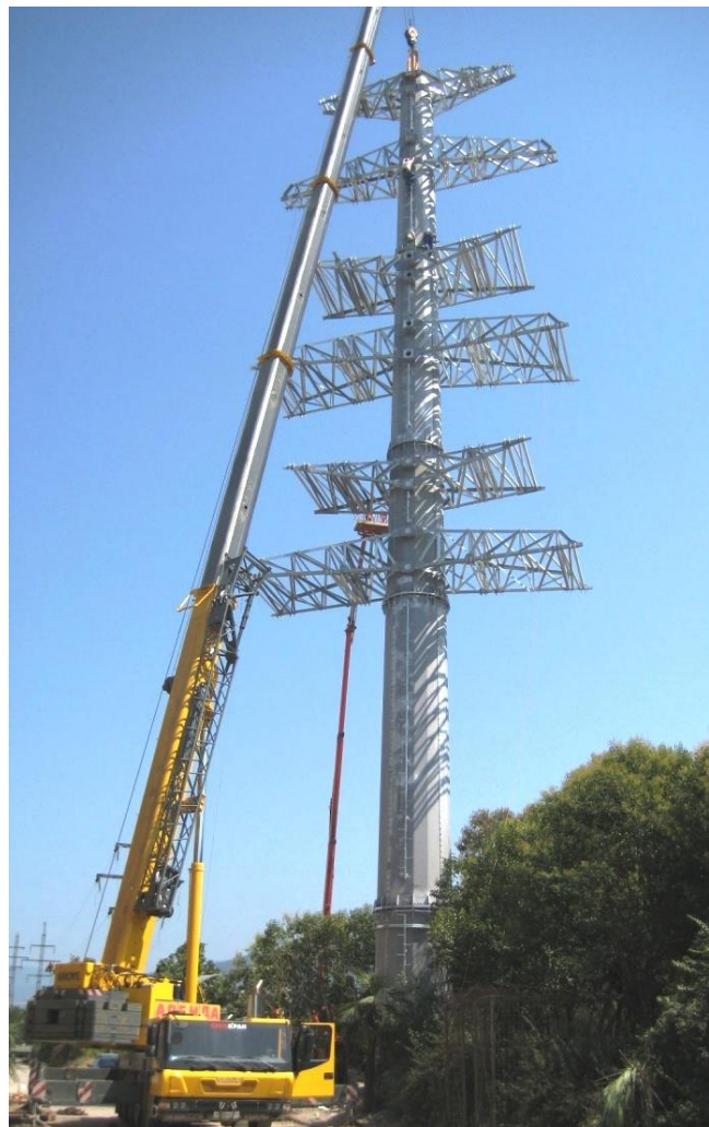
Рисунок 4 – Приклад встановлення опори багатокової ПЛ
