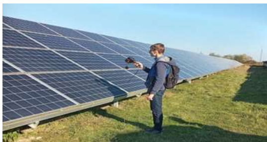
Рисунок 2 – Загальний вигляд сонячної електростанції
