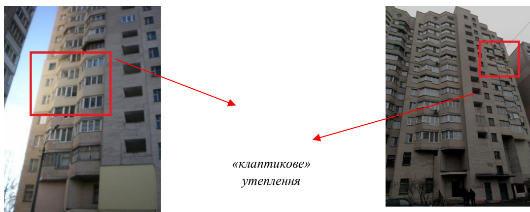
Рисунок 1 – Загальний вигляд зовнішніх стін будівлі ОСББ
