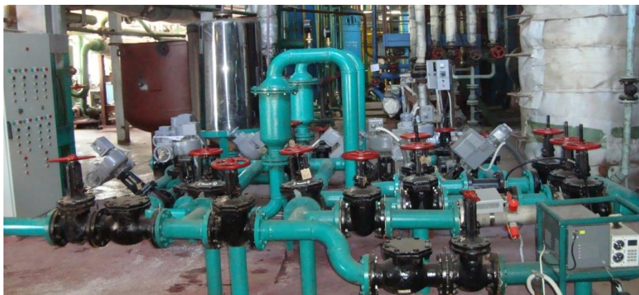
Рисунок 4 – Конструктивне рішення системи очищення фільтрату
