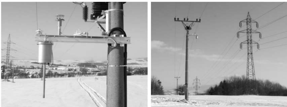
Рисунок 2 – Система моніторингу «Meteo» на лінії електропередачі
