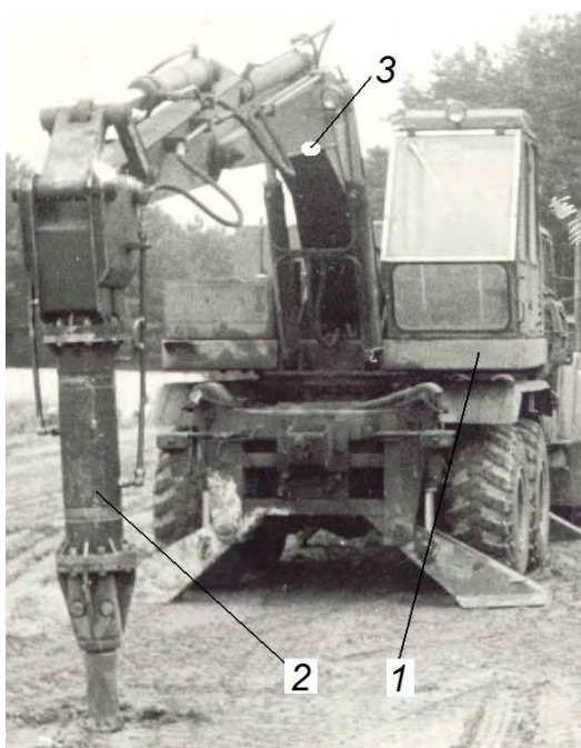
Рис.5. Екскаватор ЕО-4321 (1) з гідромолотом ГПМ-300 (2), місце установки розетки тензодатчиків (3)
