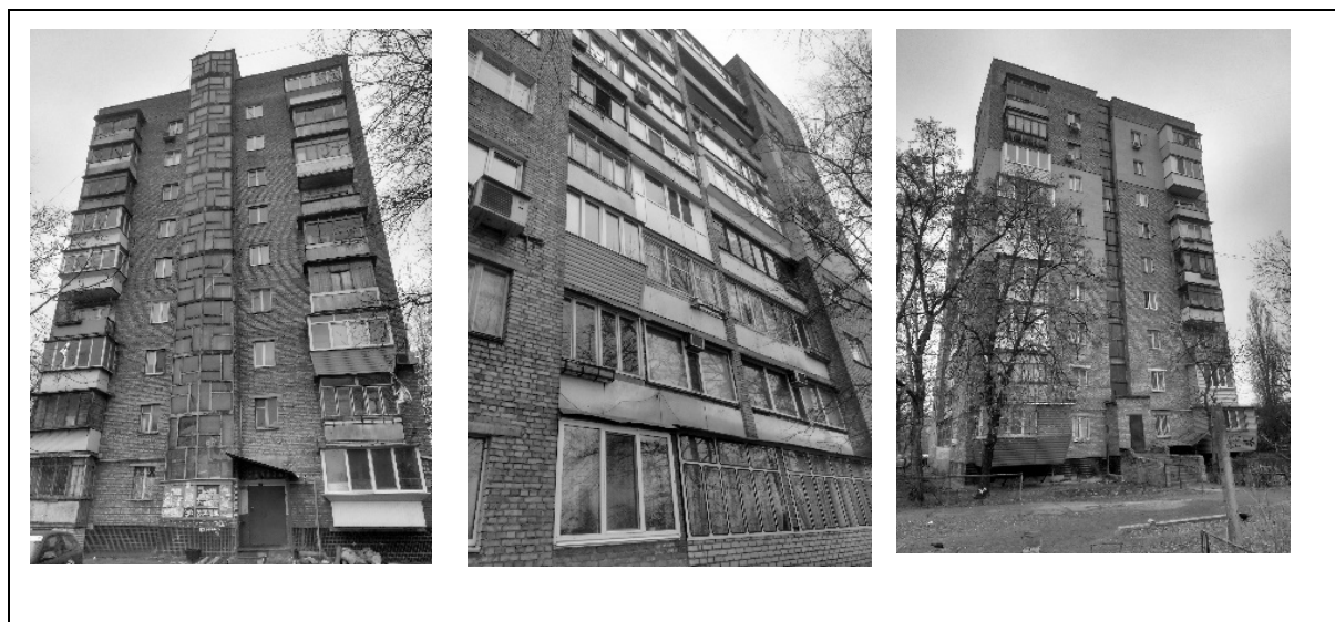
Рисунок 1 - Загальний вигляд зовнішніх стін будівлі
